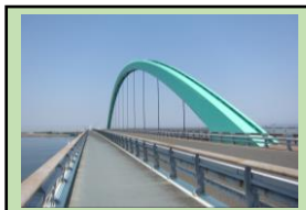
1 北九州空港連絡橋 (2.1km)
