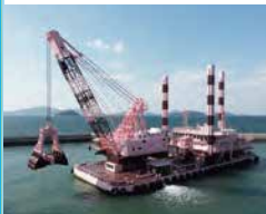
浚渫船「アポロ18号」
