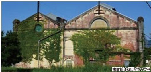
遠賀川水源地ポンプ室
